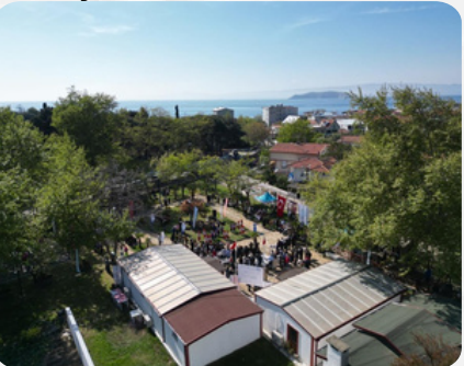
Çınarlı mahallesi Kültür Sanat Yerleşkesi tadilatı;
