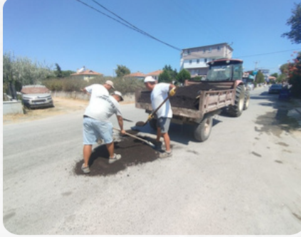
Asfalt yama çalışmaları;
