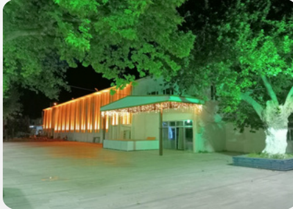
Okullar mahallesi düğün salonu tadilatı;
